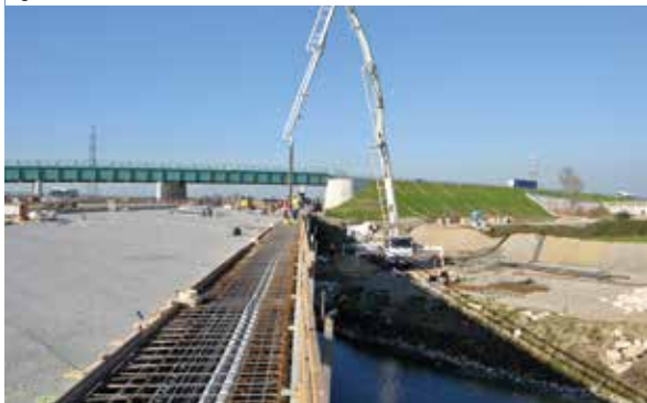
Viga de borde
